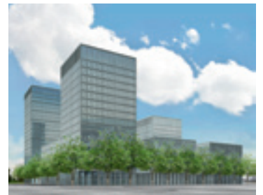
MainTower in Zürich-Oerlikon.
